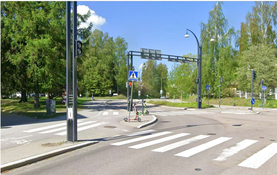
KUVA 5. Jyväskylän Vaasankadun kaksisuuntainen pyörätie liittyy Voionmaankadun yksisuuntaisiin pyöräliikenteen järjestelyihin ja kaksisuuntaisen pyörätien päättämiseksi väylä oikeassa reunassa on tarpeellinen kielletyn ajosuunnan merkki.
