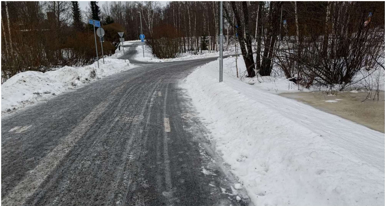
KUVA 3. Liian lähelle väylää sijoitetut valopylväät saavat väylän kaventumaan helposti, kun aurakuskin pitäisi suoralla kadulla mutkitella valopylväiden välissä ja pois aurattu lumi myös estää kuivatuksen toiminnan. Kuvan mukaiseen tilaustauteen suunnittelussa törmättiin Vuohenpellolla, pylväät asennettiin noin puoleen metriin vaikka pyöräliikenteen suunnitteluohjeen mukaan rakentamattomalla alueella ne tulisi sijoittaa metrin päähän ja sisäkaarteissa kahden metrin päähän.
